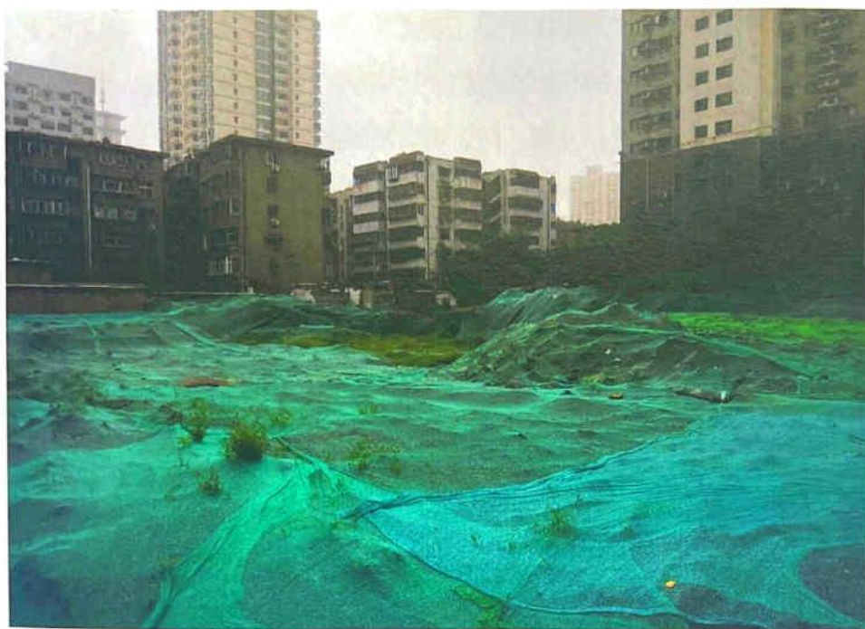
图三 勘探前现场照（南—北）
