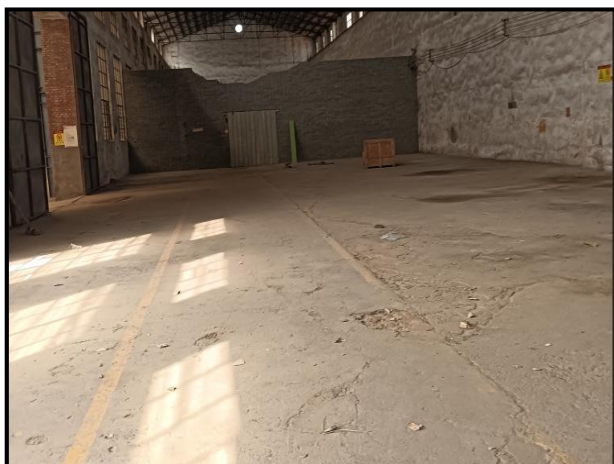
本项目车间现状
