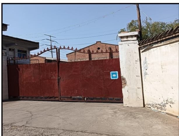
项目南侧洛阳鼎御机械设备有限公司
