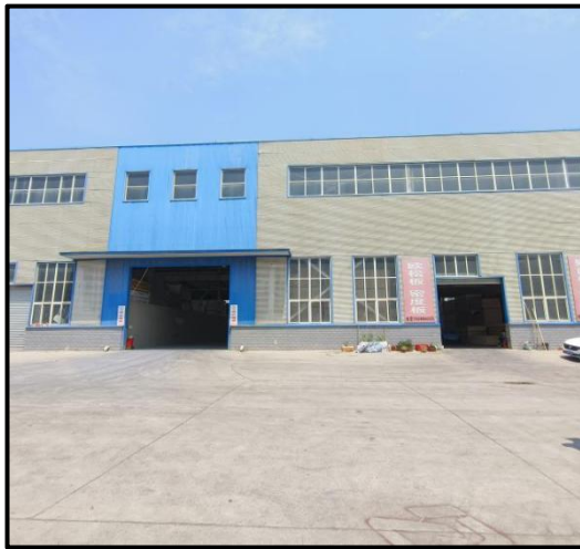
项目车间北侧仓库
